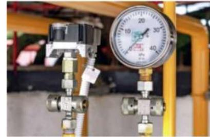
▲ Le manomètre mesure la pression de gaz dans une conduite de gaz naturel.
